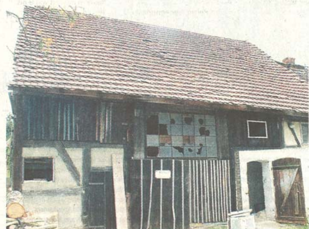
... und so die Scheune zu Beginn der Bauarbeiten. FOTOS: ANDREAS KOSKA (3)
